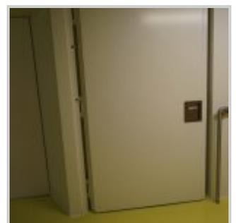
Figura 8. Porta anti incendio collocata in apposita nicchia al fine di restare allineata con la parete. Ospedale cantonale di Olten - Svizzera
