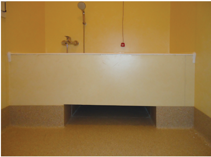
04 | Particolare dell'incavo sotto la vasca che permette l'utilizzo del sollevatore portatile Detail of the recess under the bathtub that allows the use of the hoisting equipment
